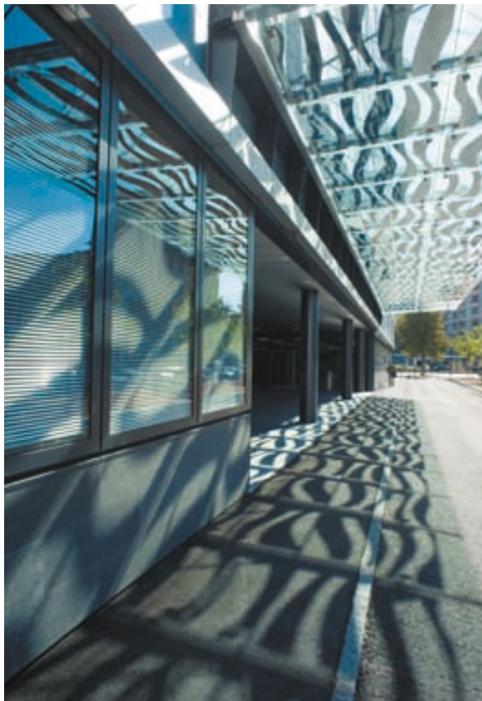
(l.) Ein interessantes Licht- und Schattenspiel empfängt den Besucher beim Eingang. (r.) Im Element der Aktiv-Air-Fassade ist auch der Sonnenschutz bereits integriert.
