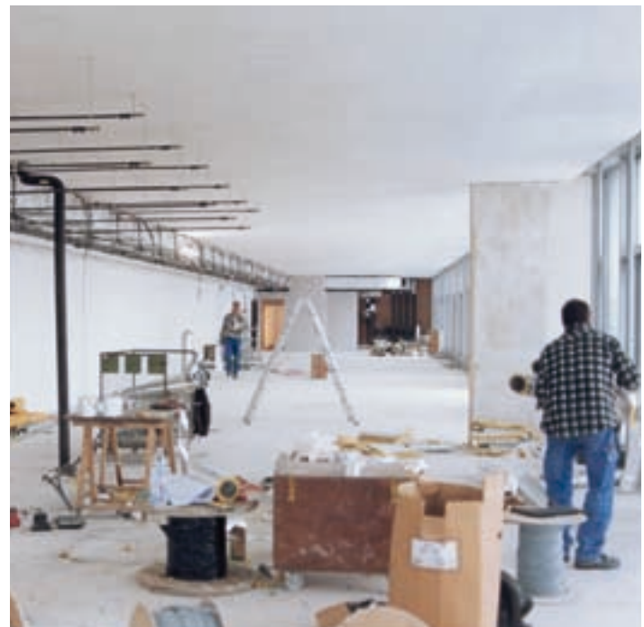
(Foto o.r.) Die vorfabrizierten Fassadenelemente werden «just in time» hergestellt. (Foto l.) Die Deckensegel beinhalten nebst Strom und Netzverkabelung auch die Heizung, die Kühlung und die Beleuchtung. (Foto r.) Eine gute Planung ist das A und O für ein effizientes Gebäude. Die Medienführung erfolgt von der Gangzone aus.
