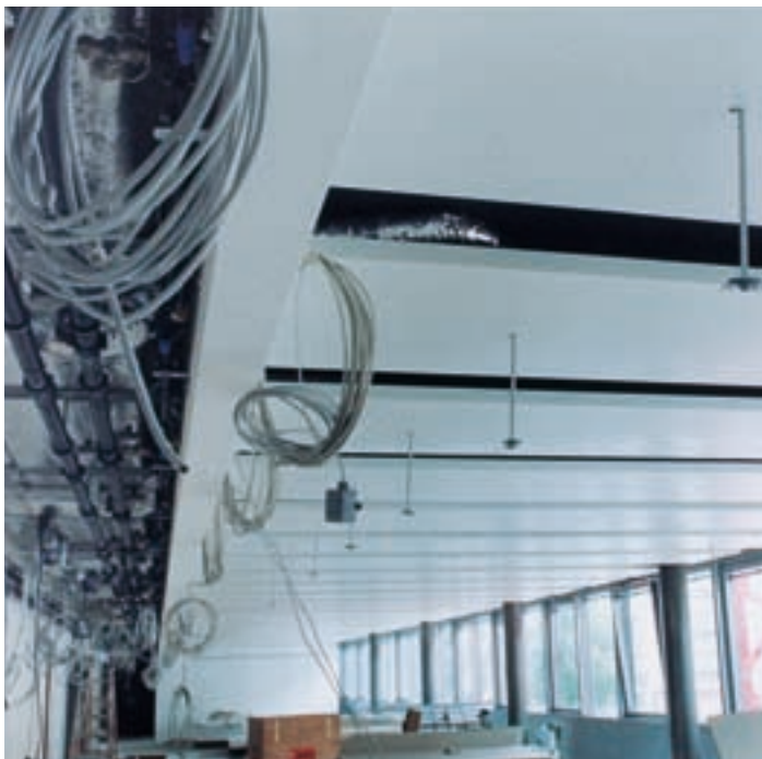
(Foto o.r.) Die vorfabrizierten Fassadenelemente werden «just in time» hergestellt. (Foto l.) Die Deckensegel beinhalten nebst Strom und Netzverkabelung auch die Heizung, die Kühlung und die Beleuchtung. (Foto r.) Eine gute Planung ist das A und O für ein effizientes Gebäude. Die Medienführung erfolgt von der Gangzone aus.
